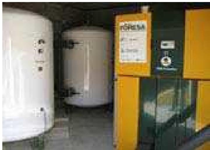
Asparreneko udal eraikinetan erabil daitekeenaren antzeko biomasa galdara (300 kW)
