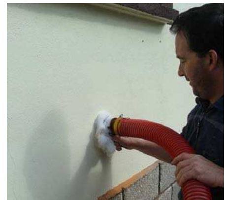
Fatxadan zelulosa injektatzen
