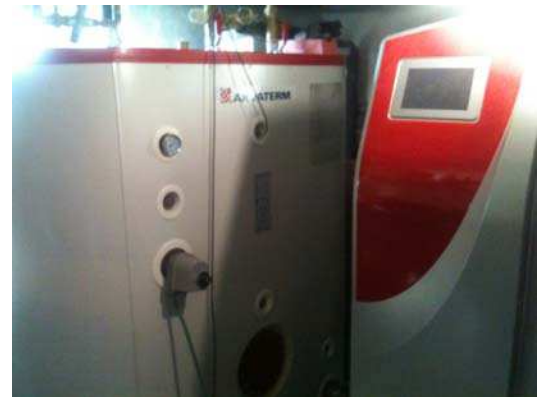
Inertzia depositua eta biomasa galdara
