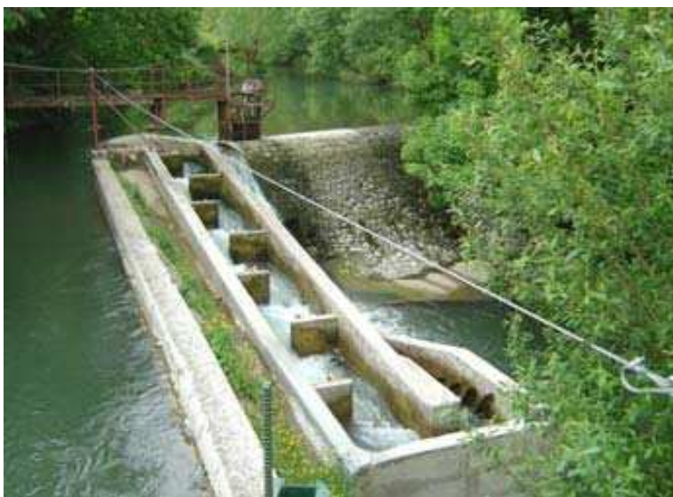
Baigorriko zentral hidroelektrikoaren irudia
