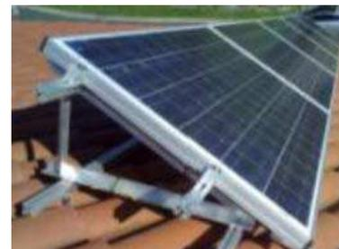
Solar fotovoltaica para cargar la pila de H<sub>2</sub>
