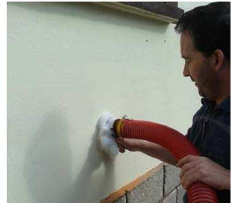
Detalle inyección celulosa en fachada
