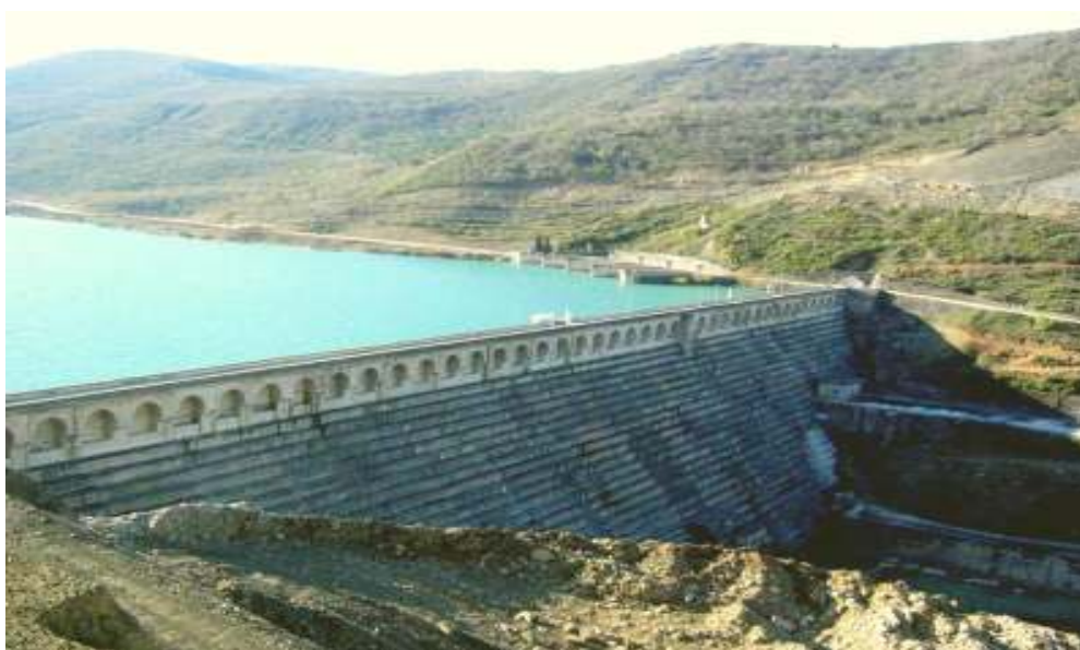
Presa de Yesa
