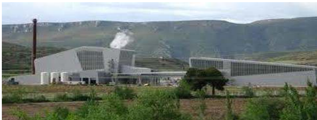
Imagen de la Planta de Biomasa de Sangüesa. Fuente: http://www.martinezoroquieta.com
