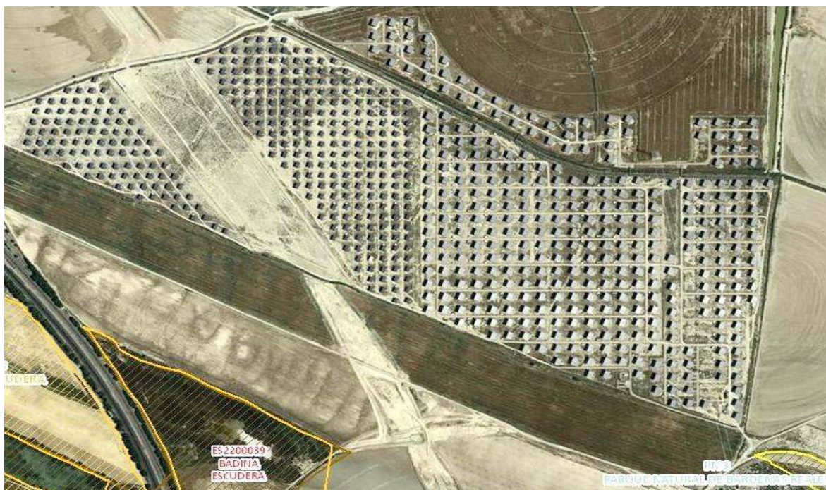
Vista aérea del parque solar Villafranca II. Fuente: Idena.
