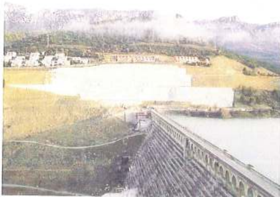
FOTOGRAFÍA 6.- Vista general de los trabajos en la ladera derecha
