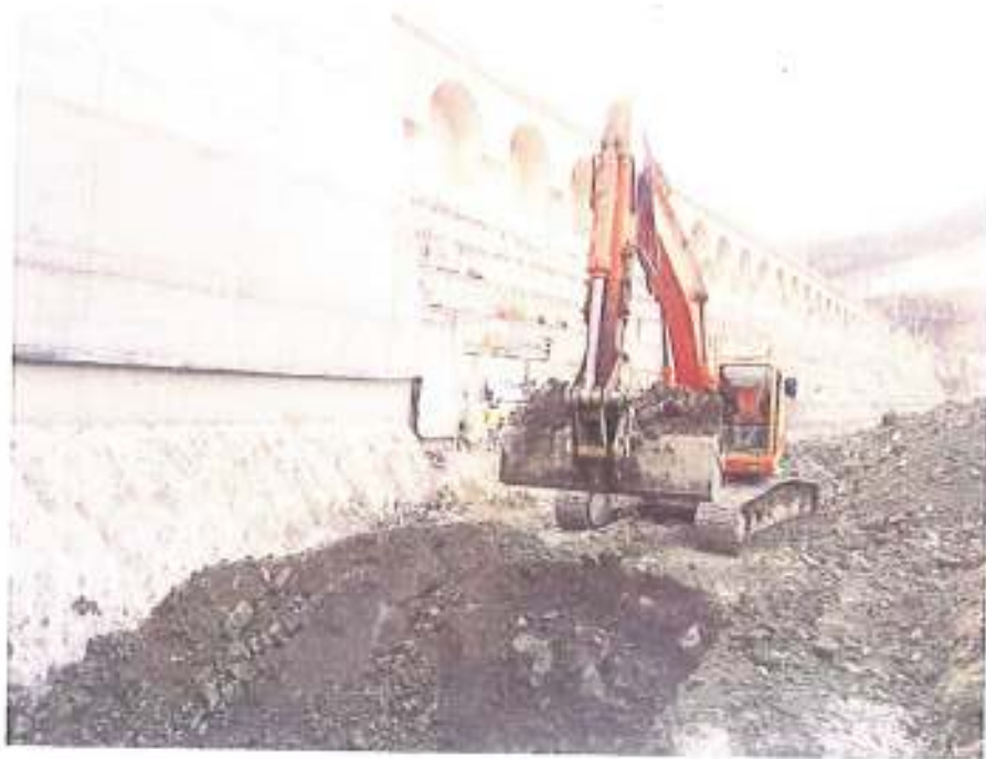
FOTOGRAFÍA 3.- Excavación aguas abajo bloques 1 y 2 de la presa existente
