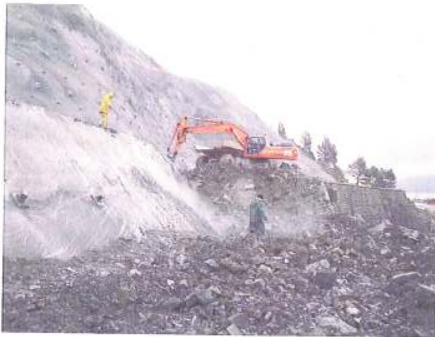
FOTOGRAFÍA 2.- Excavación entre cotas 502 - 490
