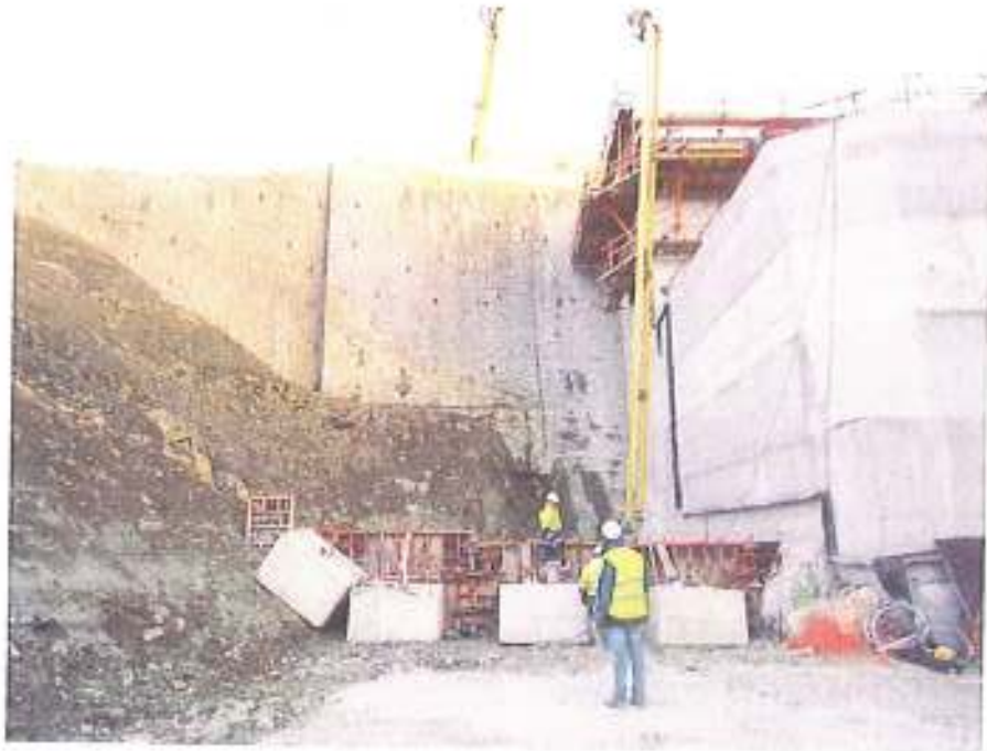
FOTOGRAFÍA 5.- Hormigonado aguas abajo bloques 1 y 2 de la presa existente
