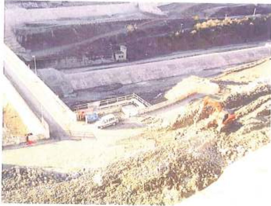
FOTOGRAFÍA 1.- Demolición muro mampostería entre cotas 502 - 490
