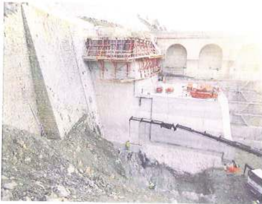
FOTOGRAFÍA 4.- Limpieza manual aguas abajo bloques 1 y 2 de la presa existente
