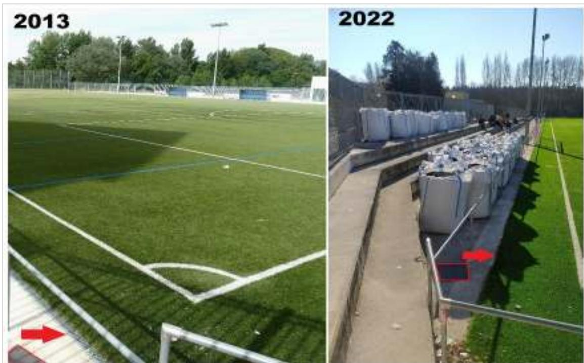
**Figura 9.** Se puede observar en el margen de la esquina noreste cómo en 2013 la rejilla de drenaje y recogida de material aún era visible. En la fotografía de enero de 2022 ya no lo es.
