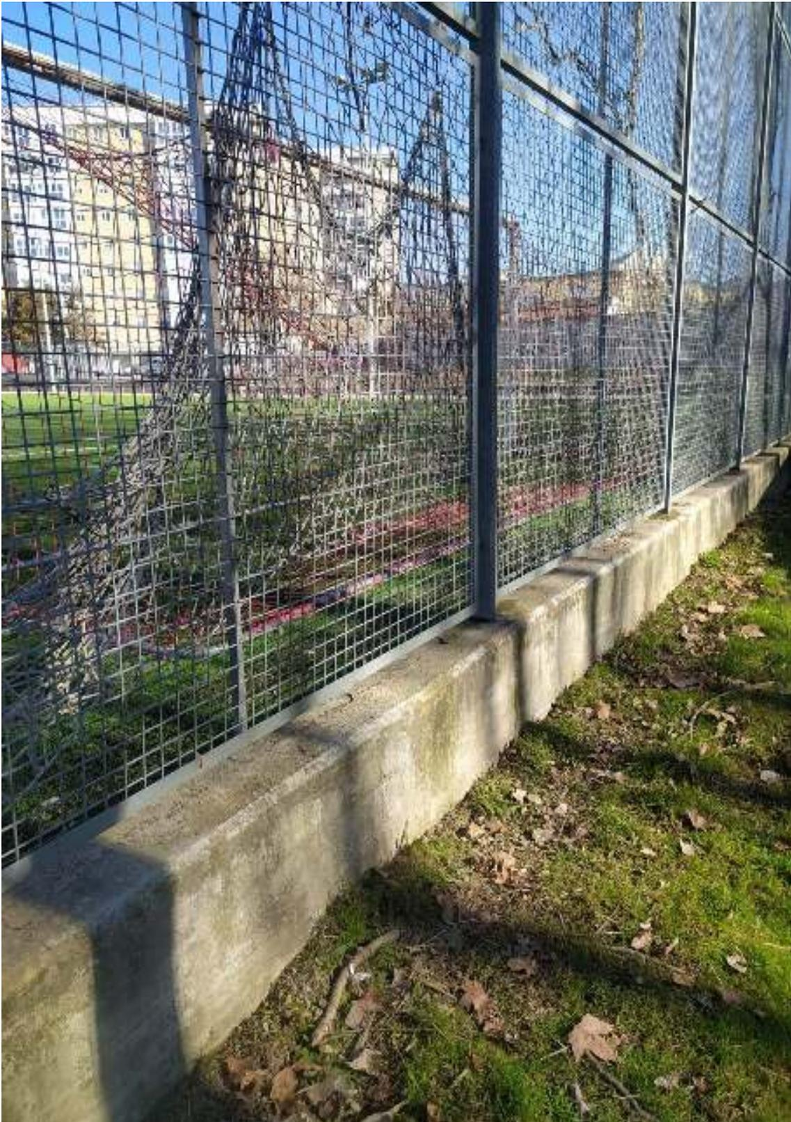
**Fotografía 16.** Zona sur. Los gránulos de caucho salen por aquí por gravedad, viento, lluvia, etc.
