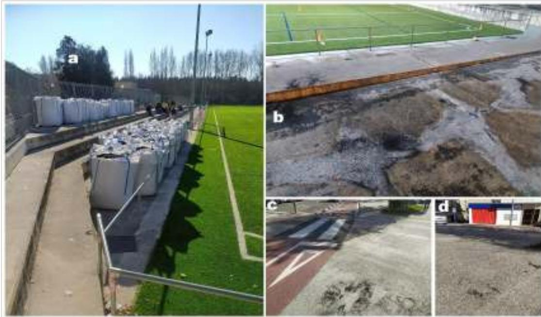
**Figura 3.** a) almacenaje de los nuevos sacos en los márgenes del campo al lado de los espectadores; b) restos de material una vez retirados los sacos superiores; c) restos de material fuera de las instalaciones cercanos al carril bici y d) restos de microplásticos junto al paso de cebra para acceder al campo.
