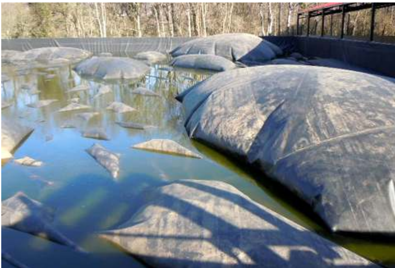
Figura 10: Fotografía de una balsa de digestatos cubierta para evitar la entrada de agua de lluvia al digestato. Se aprecian las bolsas de gases que se acumulan por la continuación de la biodigestión en el propio digestato. Fuente: planta de biometanización Bioenergía Ultzama en 2011.
